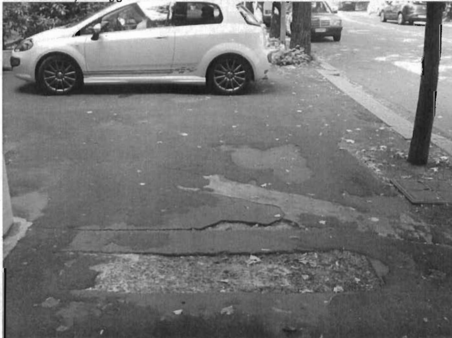
FOTO N. 5 (Ciclopedonale V.le Campari: assenza linee demarcatorie pedoni/ciclisti e pavimentazione dissestata e passaggio ostruito da macchine in sosta davanti alla autoconcessionaria)
