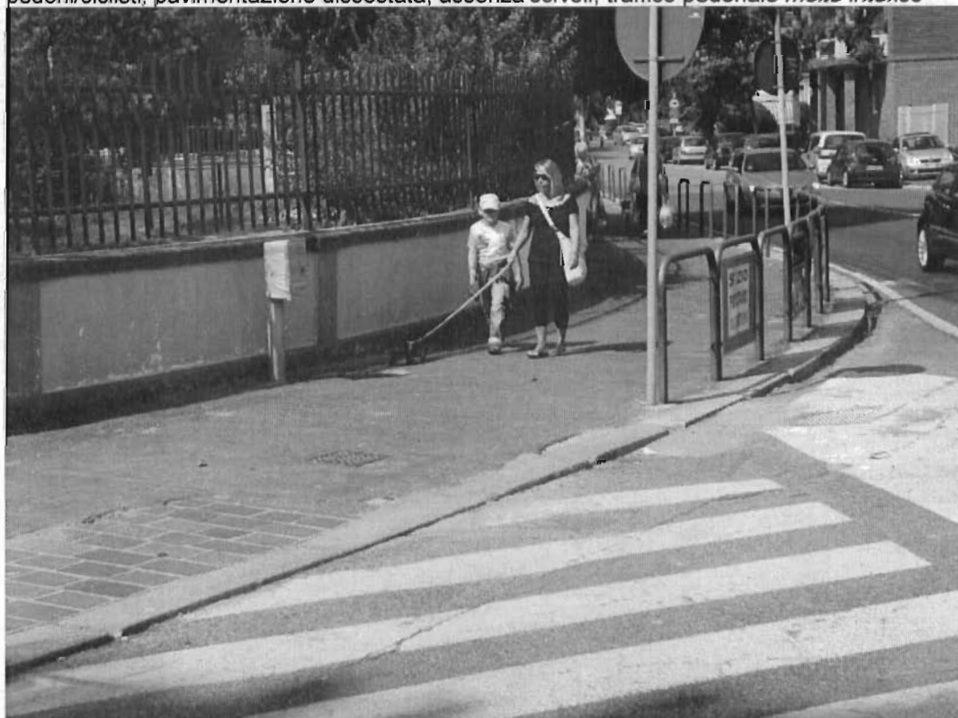
FOTO N. 10: Ciclopedonale V.le Campari (tratto limitrofo all'Istituto "Cossa"): assenza linee demarcatorie pedoni/ciclisti, pavimentazione dissestata, assenza scivoli, traffico pedonale molto intenso
