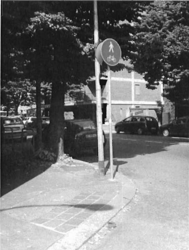
FOTO N. 2: Ciclopedonale V.le Campari: assenza linee demarcatorie pedoni/ciclisti e pavimentazione dissestata
