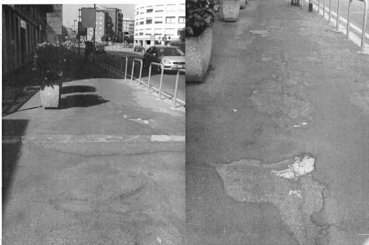
FOTO N. 6 e N. 7: Pista ciclopedonale V.le Campari: assenza linee demarcatorie pedoni/ciclisti, pavimentazione dissestata, assenza di scivoli
