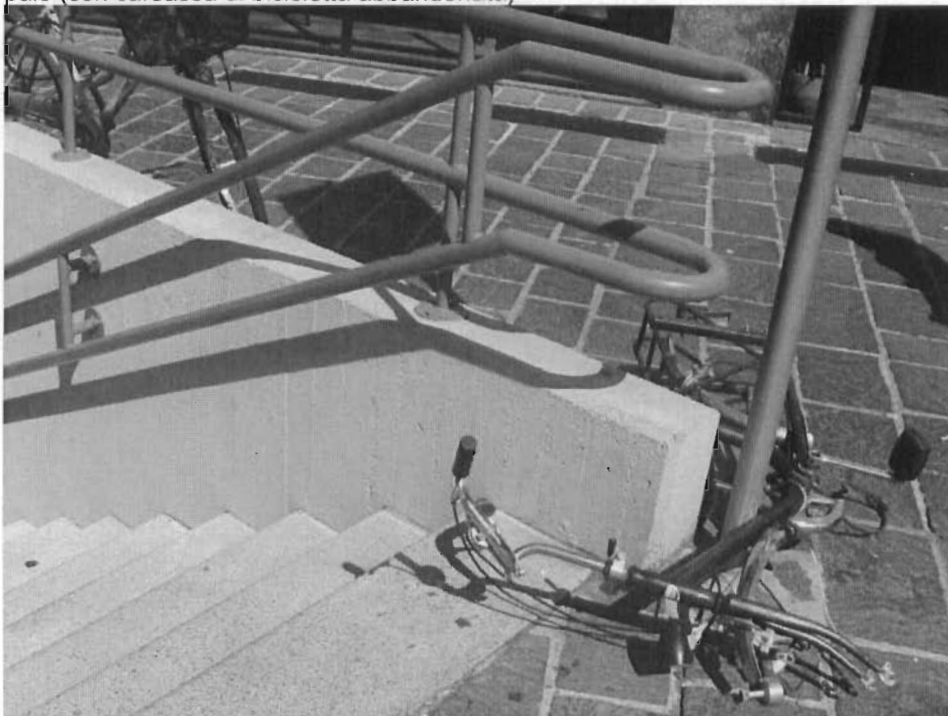
FOTO N. 2 e N. 3: Sottopasso P.zza Minerva: assenza di scivoli per il passaggio delle biciclette e per la discesa di persone disabili. Da notare, in carenza di rastrelliere, l'allaccio delle biciclette alla ringhiera ed al palo (con carcassa di bicicletta abbandonata)
